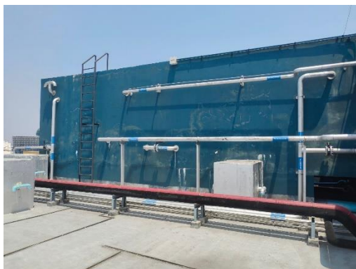
รูปที่ 54 ถังสำรองน้ำบาดฟ้า
