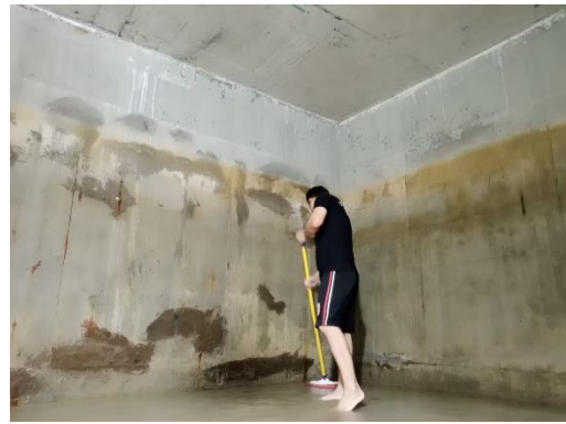
รูปที่ 38 การล้างทำความสะอาดถังสำรองน้ำ
