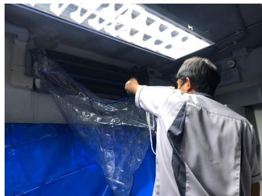
รูปที่ 25 ทำความสะอาดเครื่องปรับอากาศ
