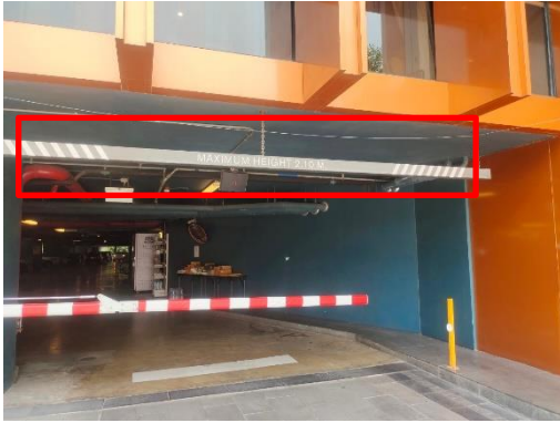
รูปที่ 6 ชุดไม้กั้นรถยนต์อัตโนมัติ / และป้ายความสูงของอาคารจอดรถยนต์
