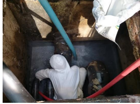
รูปที่ 48 ซุดลอกท่อระบายน้ำ
