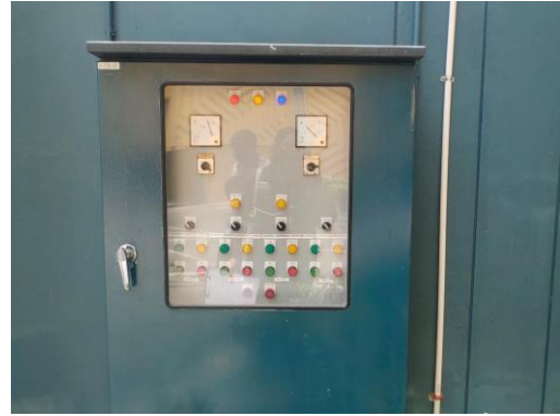
รูปที่ 41 ควบคุมระบบบำบัดน้ำเสีย
